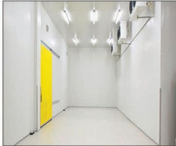
Эта панель относится к типу настенных панелей и используется при строительстве чистой комнаты (стерильной комнаты). Обычно его изготавливают толщиной 6 сантиметров, и основным отличием обычных сэндвич панелей от настенных панелей является гладкость этих панелей, поскольку для производства сэндвич панелей стерильной комнаты поверхность должна быть идеально гладкой и бесформенной, чтобы существующие твердые частицы в пространстве не собирались при формировании панелей. Качество сэндвич панелей
